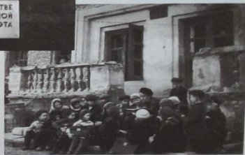
Разрушенная школа на одной из улиц Ленинграда
