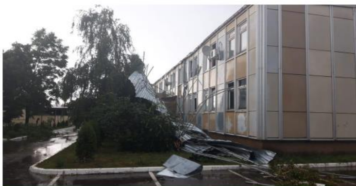
Рисунок - 1.1.8 Последствия усиления ветра в муниципальном образовании Мостовский район 27.07.2020 г.
