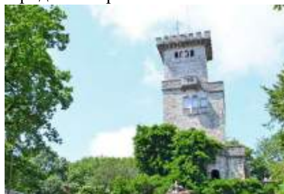
Смотровая башня на горе Ахун
